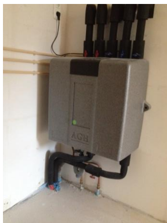
Warmte-unit in de bergkast
