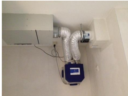
Centrale afzuigunit in de bergkast
